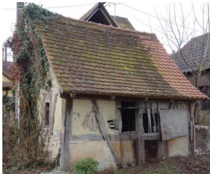
La remise, avant son démontage, dans le jardin du presbytère de Schwobsheim.
