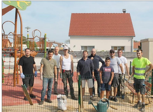
La clôture de la nouvelle aire de jeux a été réalisée. Photo L'Alsace
